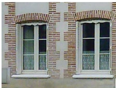
Appui de fenêtre et trumeau entre baies
