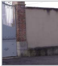
en maçonnerie enduite
