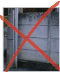
en palplanche béton
