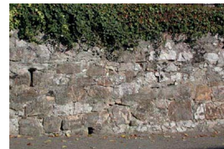
Mur de soutènement* en pierres sèches
