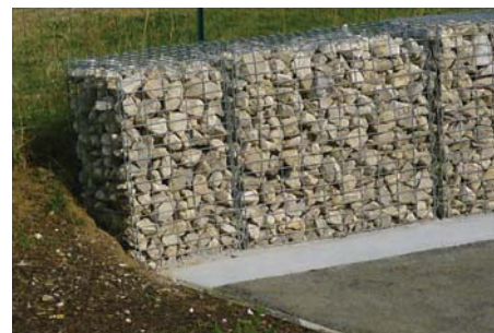
Mur en gabions*
