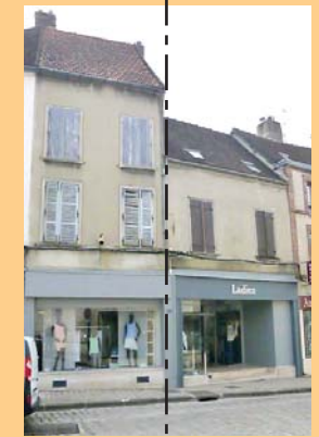
traitement discontinu sur le rez-de-chaussée par un changement de couleur
