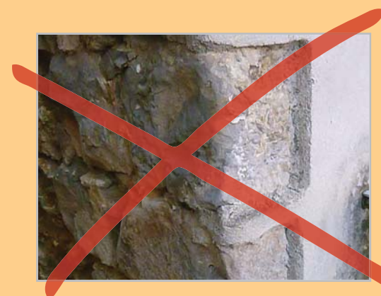
Épaisseur d'enduit par rapport à l'encadrement
